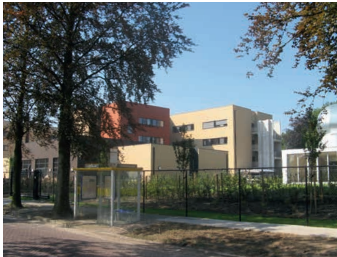
Zicht op het complex, kant dienstencentrum en tuin, met rechts het kunstwerk.
