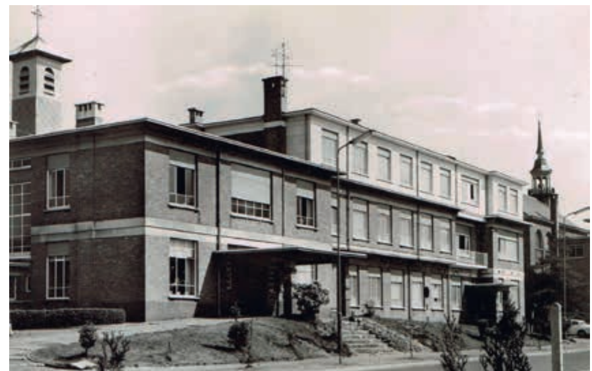
Uitzicht van het complex na het aanbrengen van een tweede verdieping, naar plannen van architect Frans Van Severen, Dendermonde.
