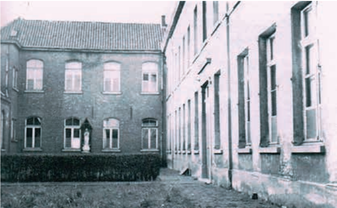
Voorhof van het godshuis, met hoofdgebouw en ouderlingenverblijf der mannen. In de bovenbalk van de ingang van het hoofdgebouw (met o.m. het verblijf van de zusters) is volgend jaarschrift of chronogram gekapt: ZIJT IN UWE GEBEDEN ALLE WELDOENERS VAN 'T HOSPITAEL GEDACHTIG. Hierin zit het jaartal 1835 verwerkt. Op deze foto (uit ca. 1938) is de gevel in verval, de luiken zijn verwijderd. Het aanpalend bakstenen gebouw, met kamers voor de oude mannen, is van latere datum (1863, deels herbouwd in 1899).
