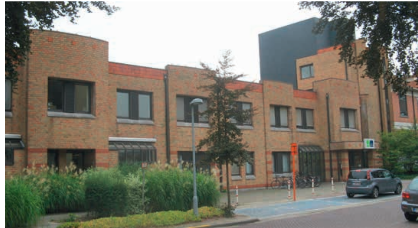
Polikliniek en dagziekenhuis, opgetrokken in een eigentijdse architectuur.
