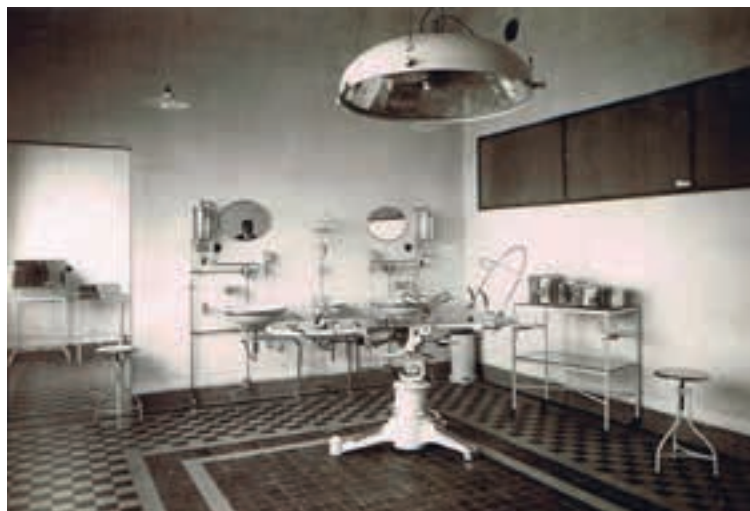
De operatiekamer op de eerste verdieping.
