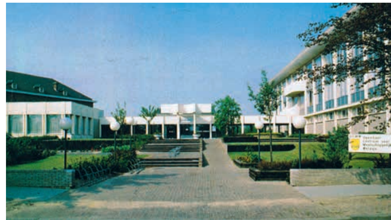
Ingangspartij voor het rustoord Beukenhof en het ziekenhuis voor chronisch zieken. Links een cafetaria, aansluitend op het rustoord. Rechts het ziekenhuis. Naar verluidt hoopte de architect dat op termijn gans de OCMW-site, in aansluiting met het parochiedomein, de Kouterkerk en de pastorie, een speels en modern tintje zou krijgen.
