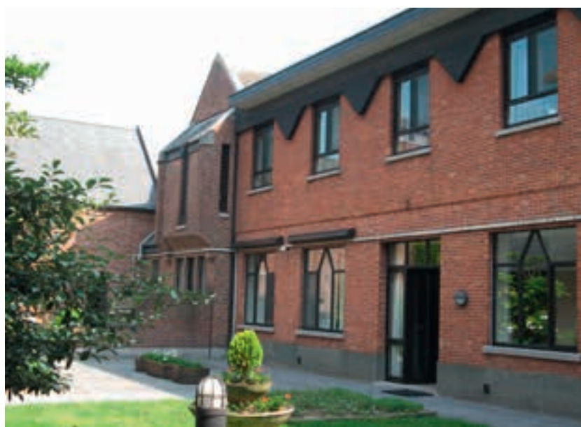
De uitbreiding van 1962, gemoderniseerd in 1984, sluit aan op nieuw toegangsgebouw.
